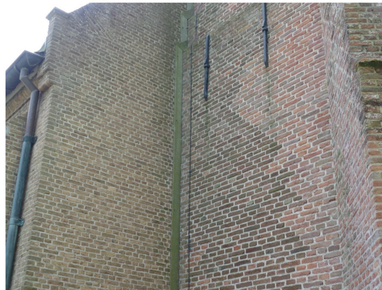
Referentie foto aansluiting toren op kerk met plank
