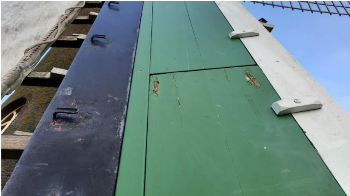
Afb.4: In de afgelopen jaren is sober herstel uitgevoerd aan het gevlucht om de draaivaardigheid te waarborgen. Waar mogelijk zullen onderdelen worden hergebruikt, waaronder de middelste en bovenste windborden.
