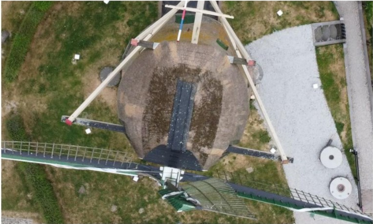
Afb.8: Bovenaanzicht van de kap met rietdek. Op diverse plaatsen is in de afgelopen jaren klein herstel verricht om lekkages te verhelpen. Het rietdek is na 37 jaar toe aan vervanging.
