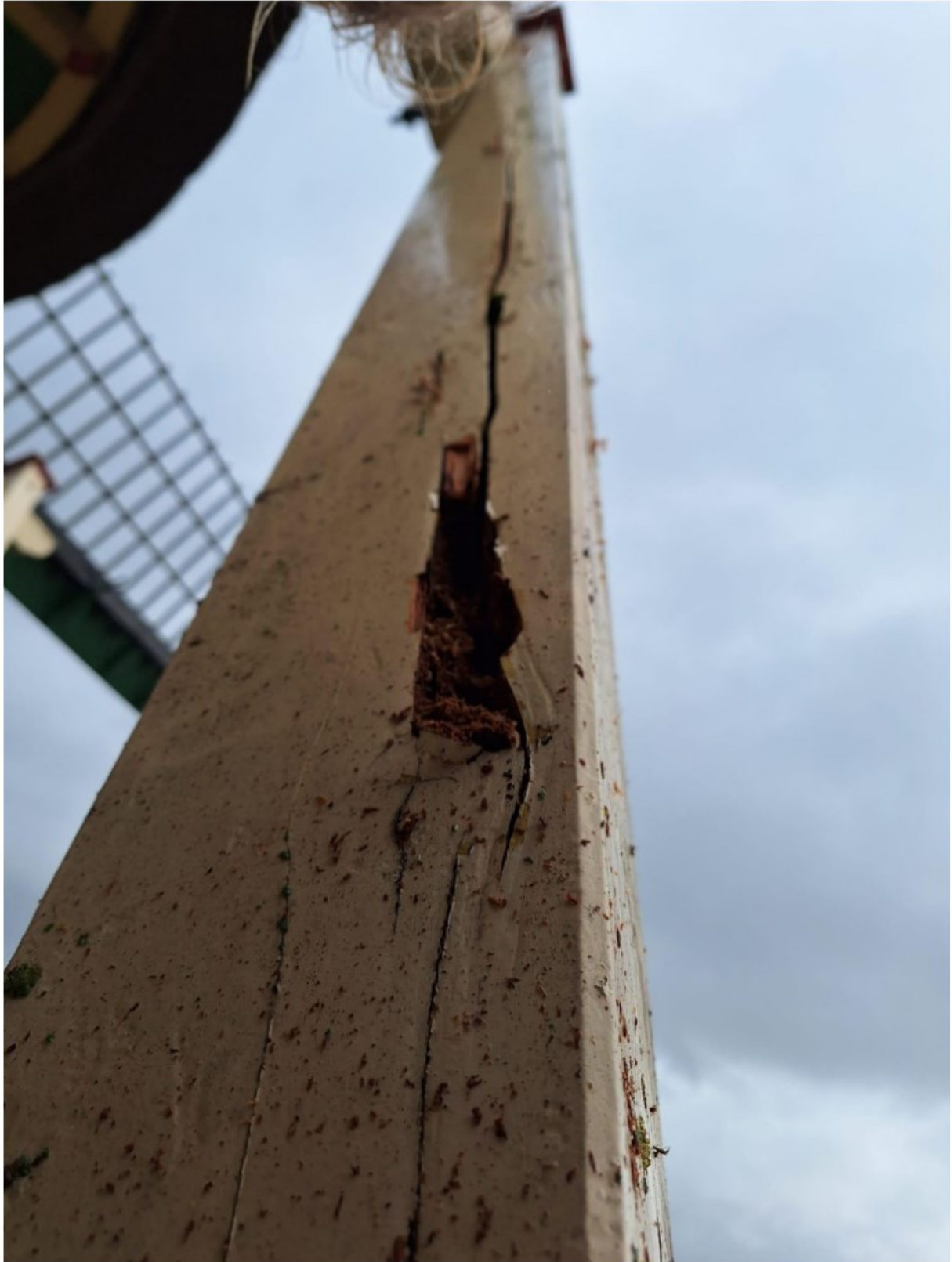
Afb.18: Houtrot in het midden van de rechter korte schoor.
