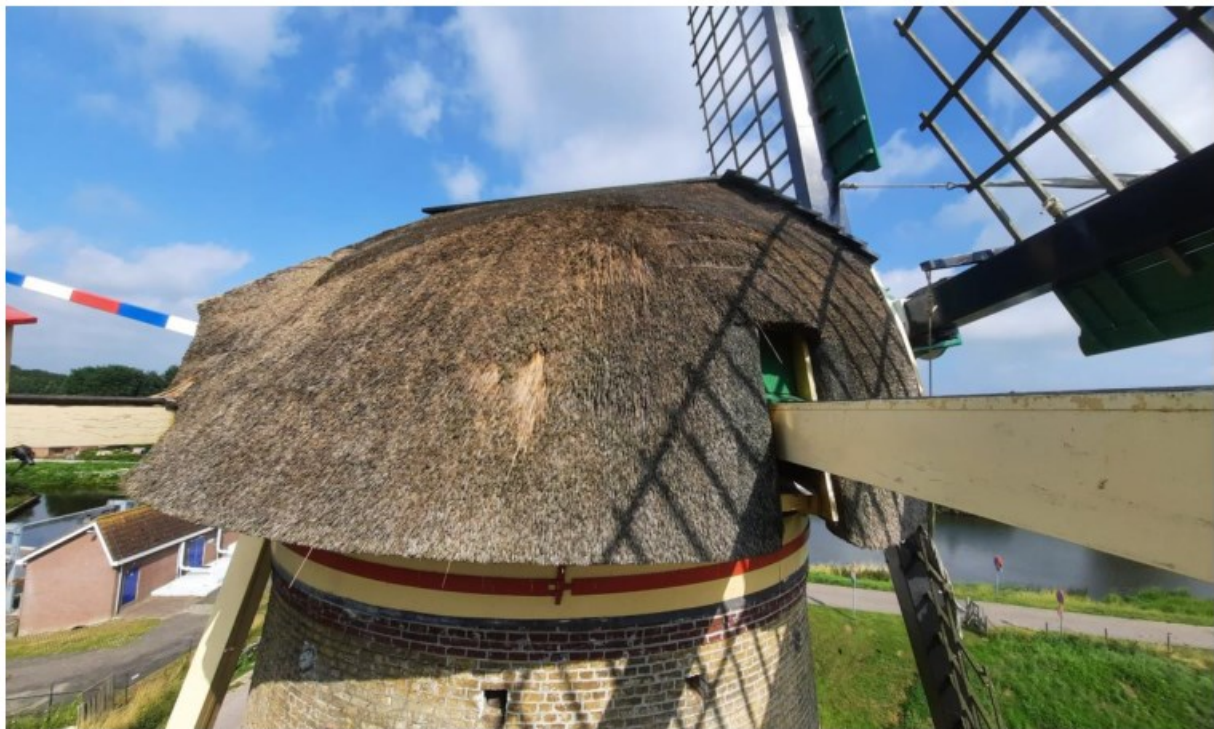
Afb.10: Zijaanzicht van de rieten kap.
