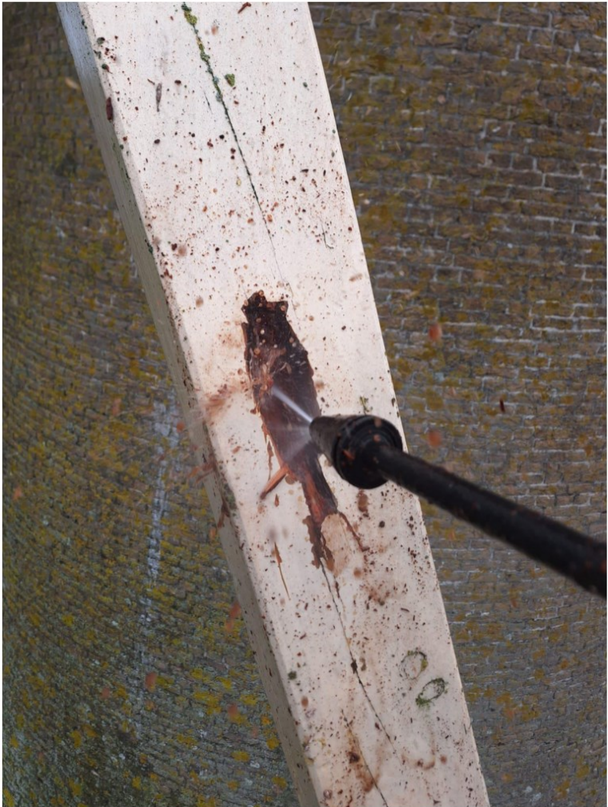
Afb.17: Houtrot in het midden van de linker korte schoor.
