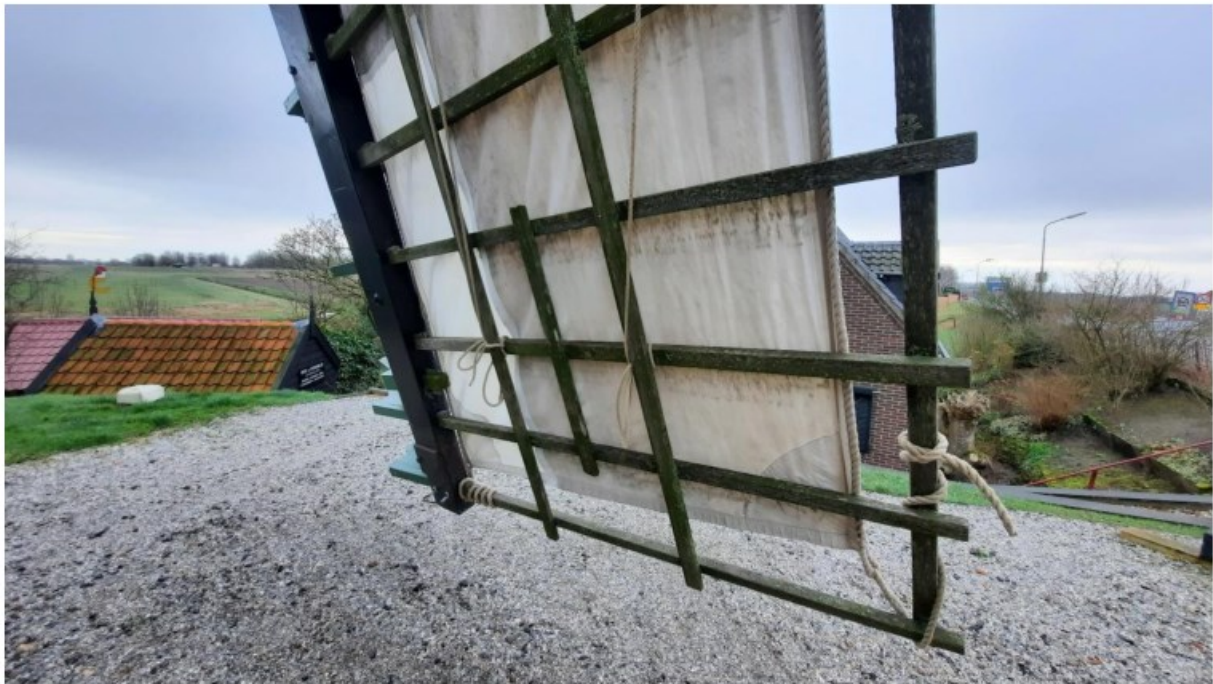
Afb.2: De roeden en tuigage dateren nog grotendeels uit 1987. Beide onderdelen zijn toe aan vervanging.
