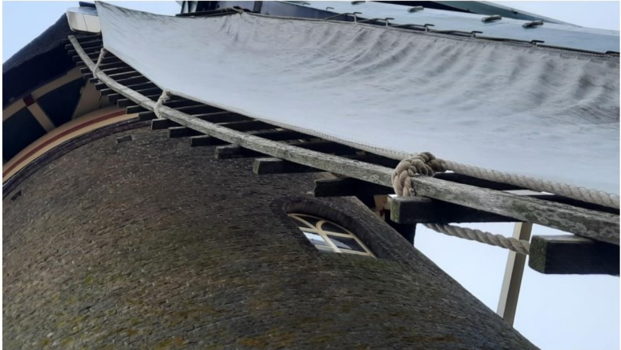
Afb.3: Een groot gedeelte van de heklatten verkeren in matige tot slechte staat. In het kader van de veiligheid voor vrijwilligers en omgeving is volledige vervanging wenselijk.
